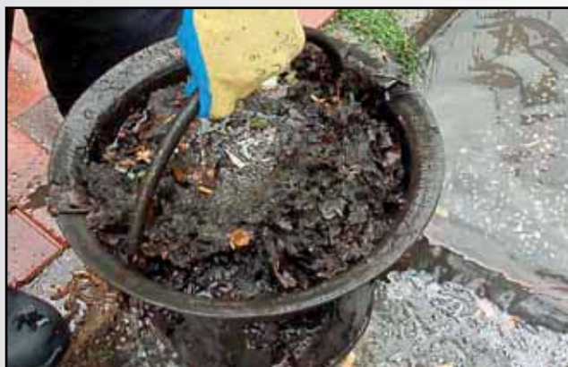
Reinigen der Gullys bei Starkregen
