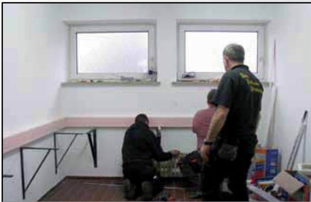
Die neue Arbeitsplatte wird montiert
